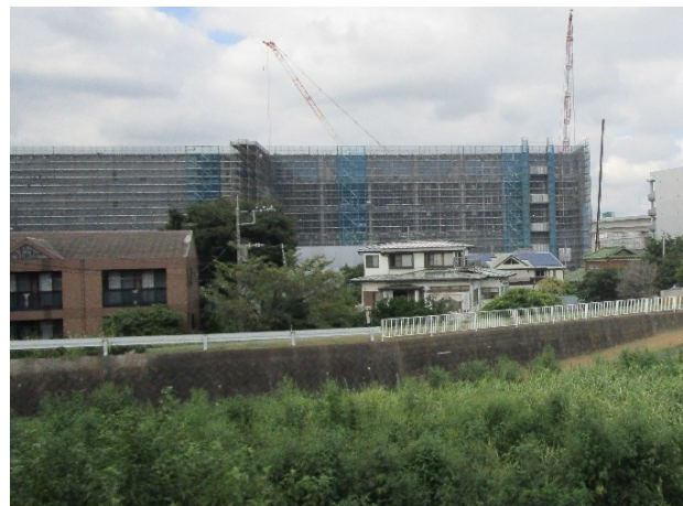
大手物流会社の倉庫群建設 建設用大型クレーン立ち並ぶ
