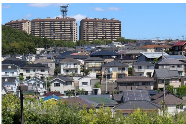
戸建てとマンションが整然と立地（中川）
