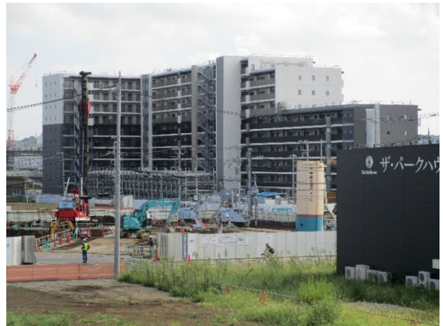
建設中マンション（川和町駅前南側）
