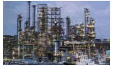
石油精製工場
