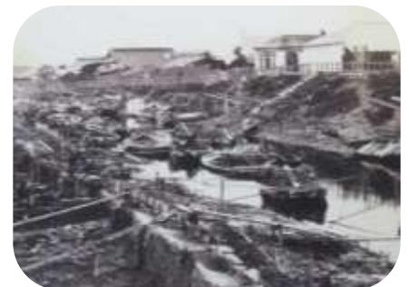
川幅を広げる工事
