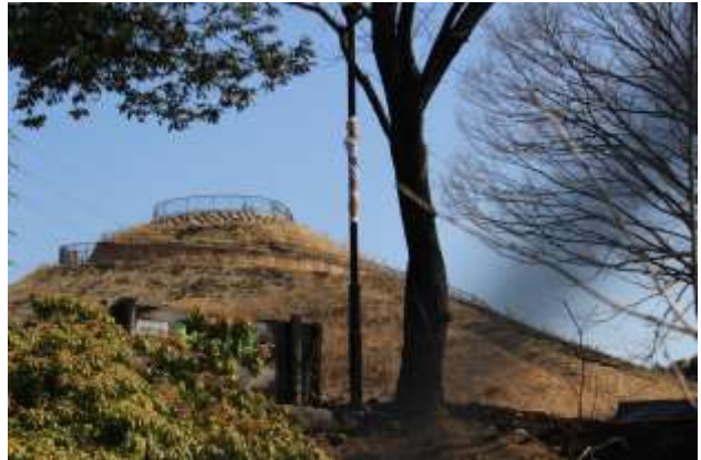
川和富士公園は工事中（2013.3.1）
