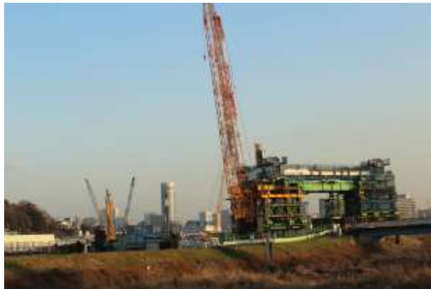
環状道の工事は急ピッチ！
