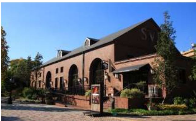
麒麟ビール横浜工場
