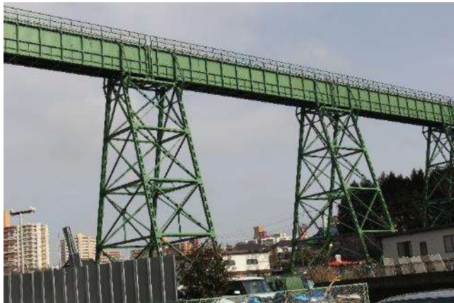
大貫谷戸水路橋
