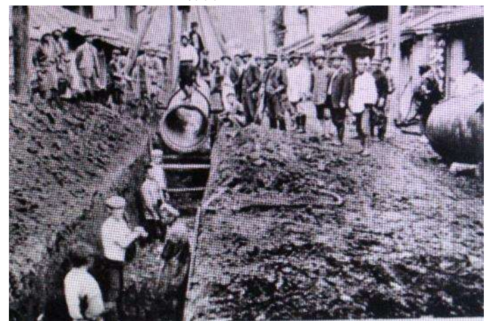
水道管敷設工
