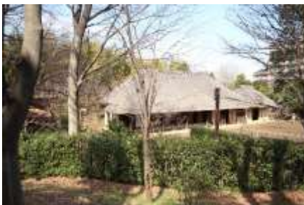
馬屋を取り込んだ民家
