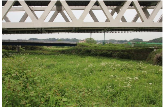
鶴見川との合流点に架かる橋 (トラス構造)
