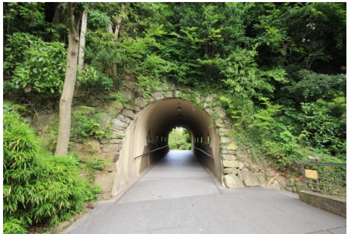
金沢文庫へ続く隧道
